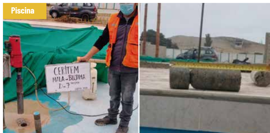
Piso de la piscina construido en dos etapas. Una etapa de concreto armado y otra de concreto simple.
