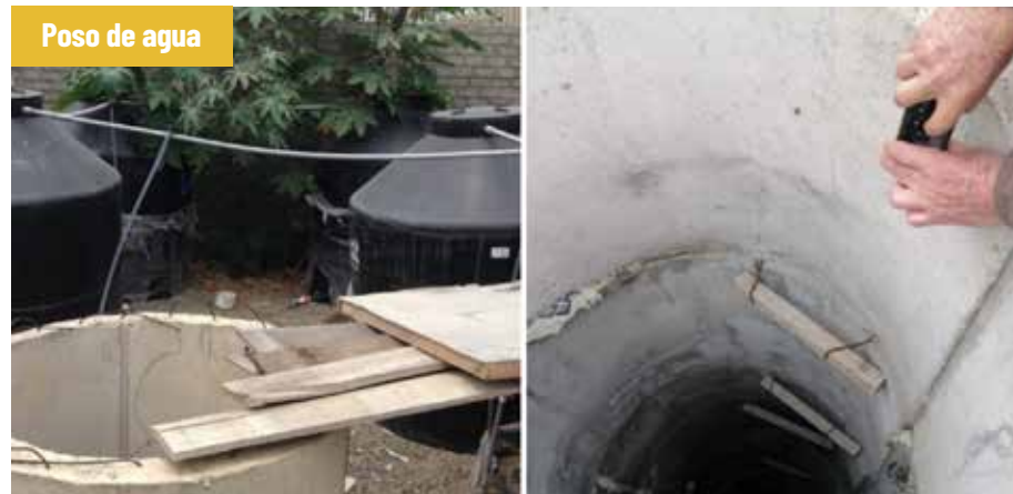
Pozo de agua que nunca funcionó por su mala ubicación.
